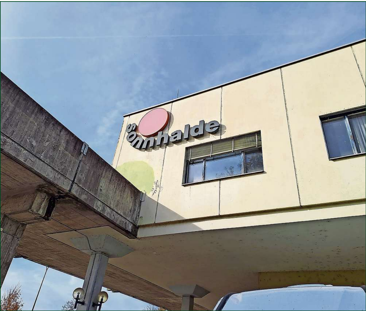
Der «Eintritt» in die Sonnhalde-Siedlung soll baldmöglichst in neuem Glanz erscheinen. Bild: sj
